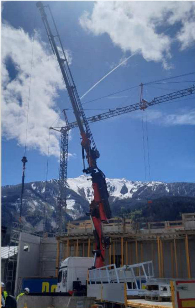
In Landeck in Tirol haben wir mit dem PK580 Container verhoben.
