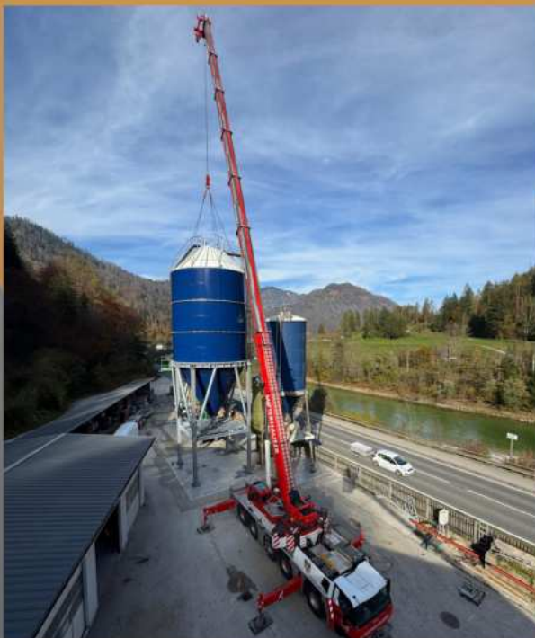
Unser 120 Tonnen Grove beim Silo Versetzen in Bad Ischl im Oktober 2024.
