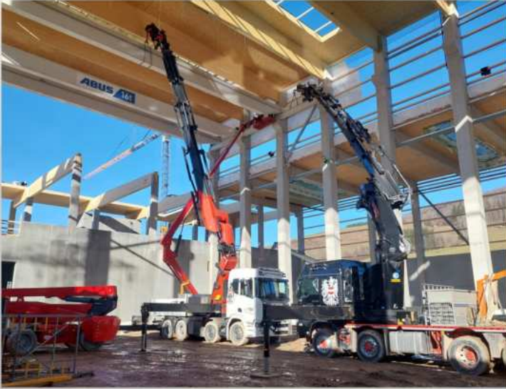
Hallenkran Montage mit PK1650 und Effer1405 in Salzburg im Jänner 2024.
