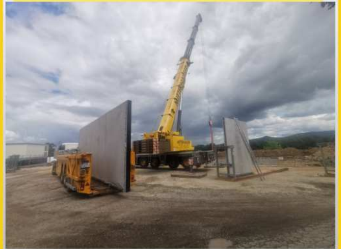
Transport mit Innenlader eines Fertigbetonteil in Gmunden.
